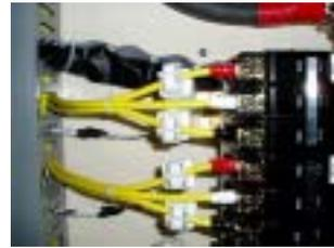
また、最近では遮断器に電力計測機器が付属した遮断器が各メーカーから発売しています。（右図 計測機能付遮断器）
